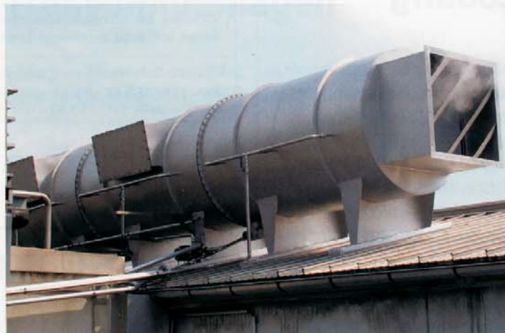
Fercher ist Entwickler und Hersteller von Anlagen zur Wärmerückgewinnung aus Abwasser-, Abluft- und Rauchgasquellen spezialisiert. Im Bild ein Abluftwärmetauscher.
